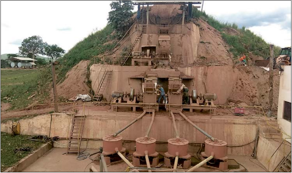
Foto 7 Planta de concentración gravimétrica San Ramón - Santa Cruz (2019).
